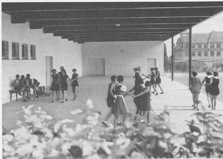
Abb. 10. Offene, gedeckte Pausenhalle, links Turnhalle, hinten Geräte Räume
