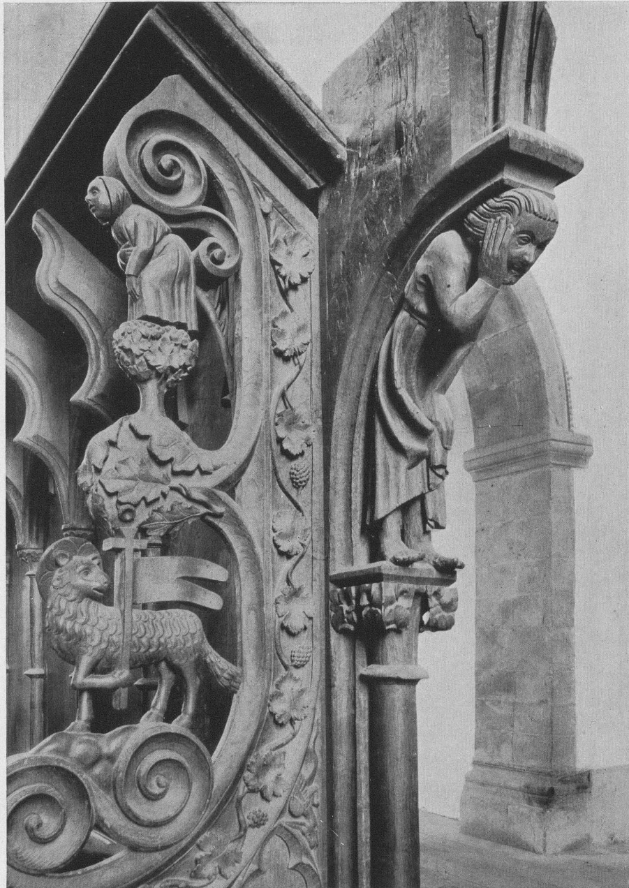
Aus der Klosterkirche Kappel Einzelheiten des Chorgestühlabschlusses und Durchganges ins nördliche Querschiff 13. Jahrhundert
