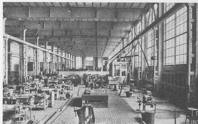
Abb. 2. Werkstattgebäude (1930) bei Gebr. Sulzer, Winterthur
