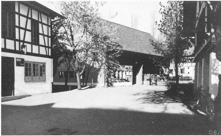
Abb. 48. Die Dorfstrasse gegen Osten, links das Postamt im Gemeindehaus
