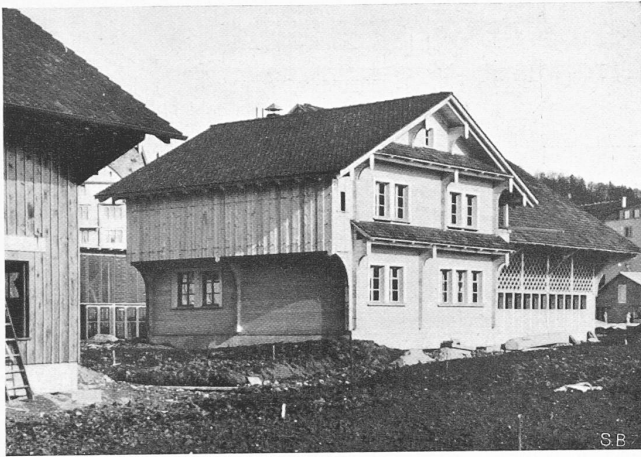
Abb. 50. Bergbauernhaus aus Südwest
