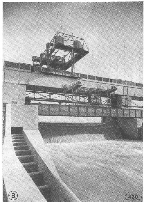
Wehranlage Klingnau, Ansicht von Unterwasserseite mit Dambalkenkranen
