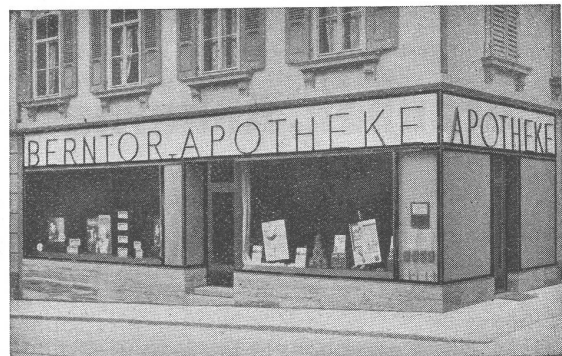
Schaufensteranlage inkl. Metalltüre sowie Bronzeschrift montiert vor durchleuchtetem Opalüberfangglas.
