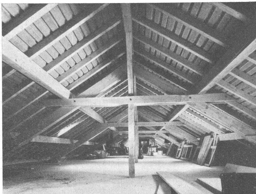
Fabrikgebäude in Heerbrugg.
