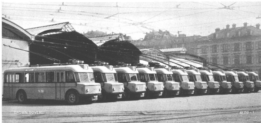
Ein Teil der 32 Trolleybusse der Strassenbahn Lausanne (elektr. Ausrüstung Brown Boveri)
