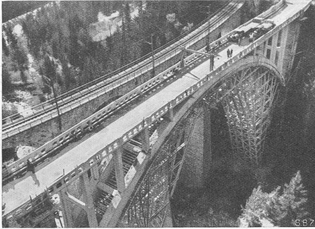
Abb. 10. Fertige Brücke mit dem Lehrgerüst
