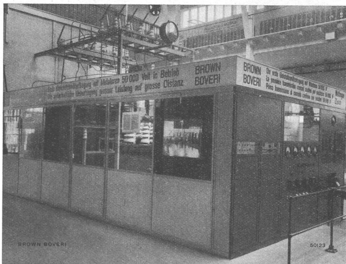
Gleichstrom-Kraftübertragung Wettingen-LA mittels Mutatoren. Umformung des ankommenden Gleichstroms in Drehstrom.
