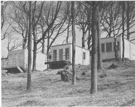
Abb. 14. Kleine Häuser der Elementbauweise, in Schweden
