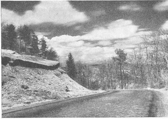
Abb. 6. Der durch Strasseneinschnitt hässlich angerissene Hang sollte mit Strauchwerk bepflanzt oder dann flacher abgebösch, mit Humus überdeckt und mit Rasen begrünt werden
