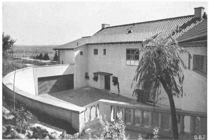
Abb. 6. Bergseitiger Hof, gegen Süden gesehen, Hauseingang, Garagetor
