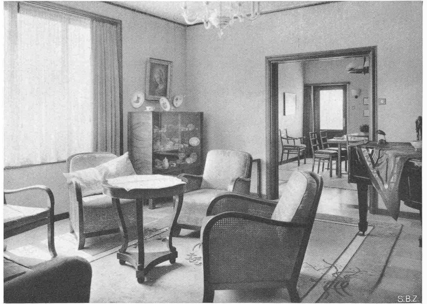
Abb. 16. Empfangszimmer, mit Durchblick gegen das Esszimmer
