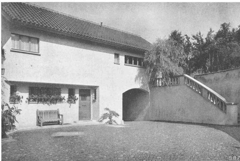
Abb. 8. Hofbild gegen Diensteingang und Einfahrt, gegen Norden
