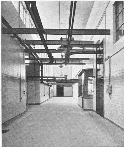
Abb. 9. Verbindungsgang mit Hoch- und Niederbahn von den Schlachthallen (rechts) zum Abtropfraum und den Kühlräumen (links). In der Mitte die Waagmeister-Zelle
