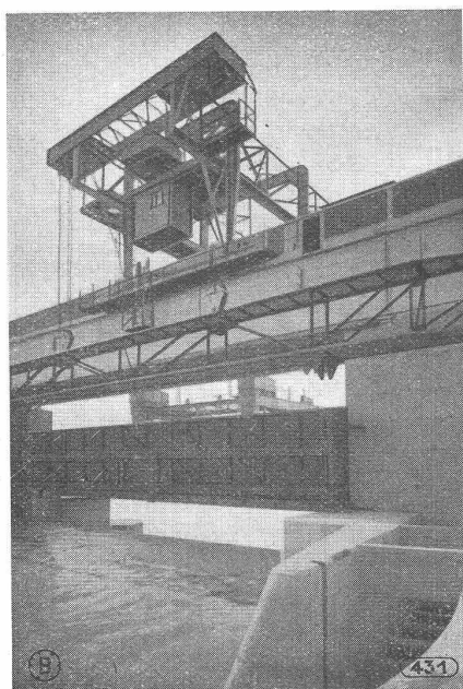
Stauwehranlage Klingnau, Ansicht von Oberwasserseite mit Dammbalkenkränen.
