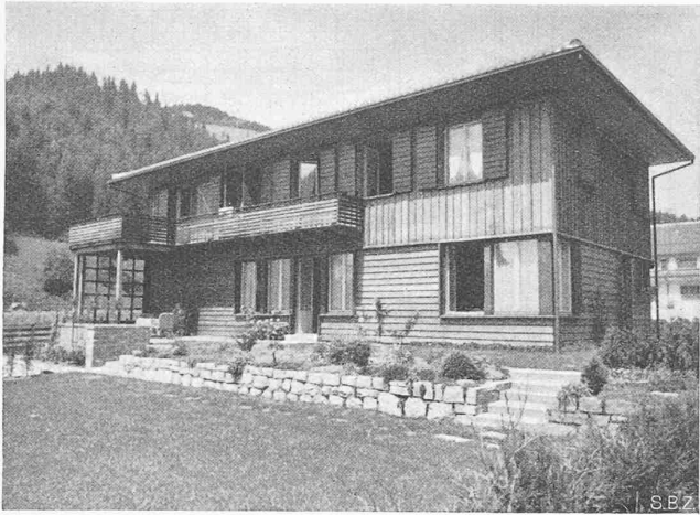
Abb. 2. Arzthaus in Trubschachen, aus Süden
