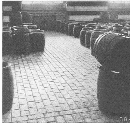
Abb. 2. Holzpflasterboden aus prismatischen Eichenklötzli, in einer Brauerei
