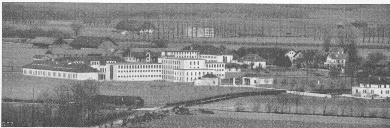
Fig. 2. Vue générale prise du côté ouest du pénitencier de Bochuz, à droite l'habitation du directeur. — E. VIRIEUX, arch. de l'état, Lausanne
