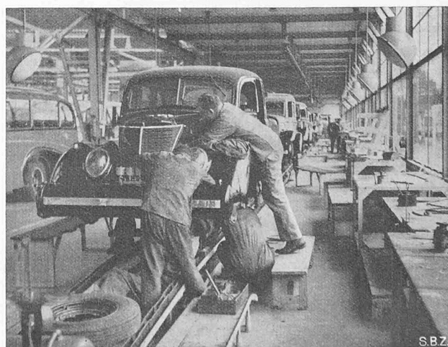
Abb. 8. Vier Mann beim Einbau von Generatoranlage, Wasserabscheider und Leitungen auf dem Montageband
