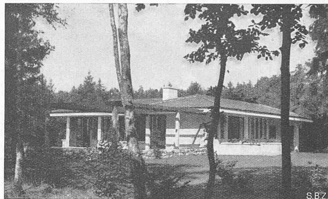
Abb. 8. Ansicht aus Osten
