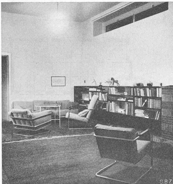
Abb. 10. Wohnhalle, rechts oben Lüftungsschlitze
