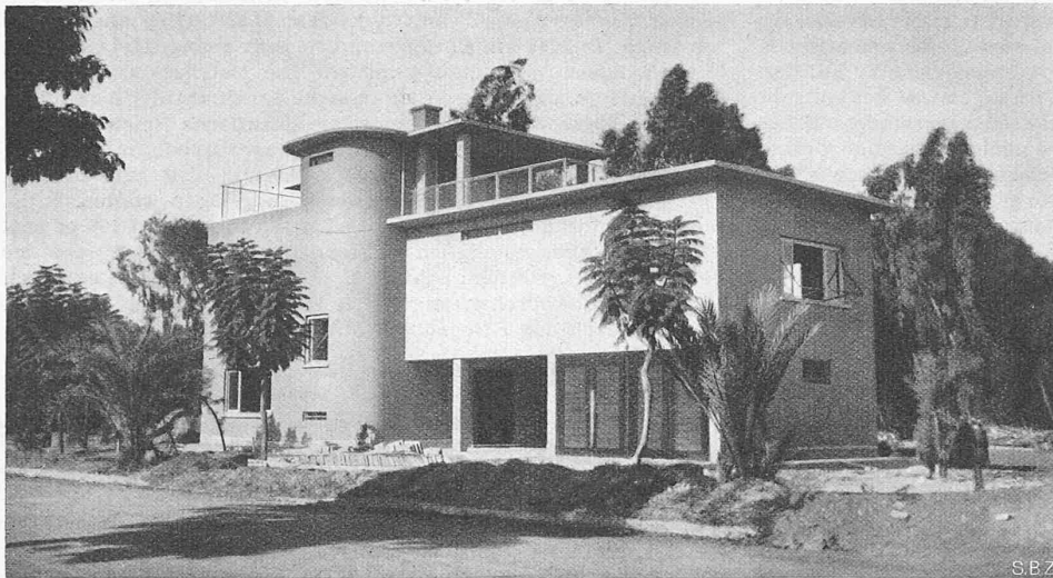
Abb. 8. Strassen-(Südost)-Seite des Wohnhauses bei Kairo. Architekt CHARLES HOCH †
