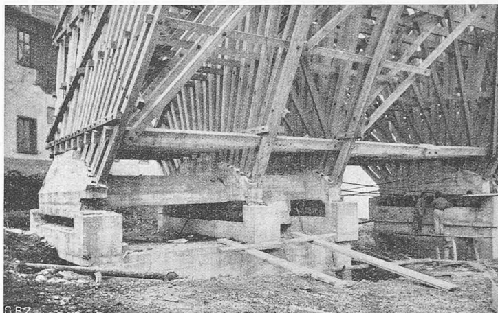
Abb. 21. Linksufriger Gerüstfuss auf den Auflager-Sätteln
