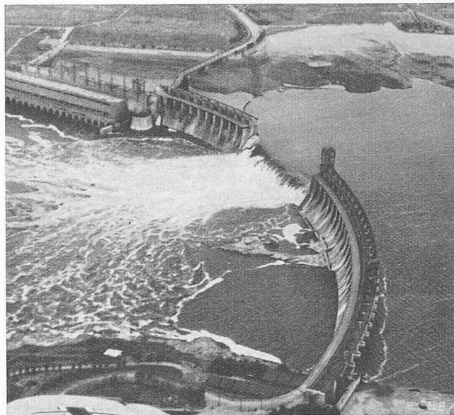
Der Ende August 1941 gesprengte Dnieprostroï-Staudamm
