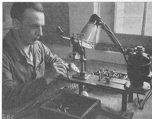
Bohren feiner Einspritzdüsenlöcher
