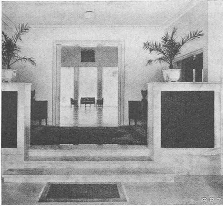
Abb. 12. Vestibül des Haupteingangs
