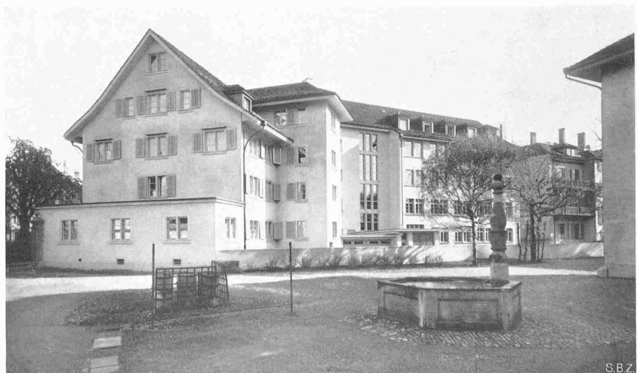
Abb. 4. Grosse Pelikan, Hofansicht aus Westen, rechts der rückwärts viergeschossige Neubaufügel
