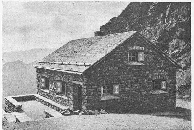
Abb. 3. Neue Medelserhütte des S. A. C., aus Südosten
