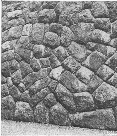
Abb. 8. Schlechte Zyklopenmauer aus braunem Numulitenkalk zusammengewürfelt
