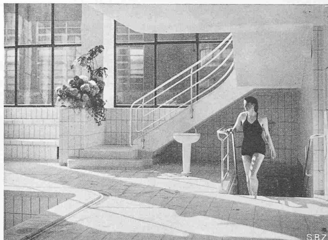
Abb. 13. Treppenaufgang in der nördlichen Schwimmhallen-Ecke
