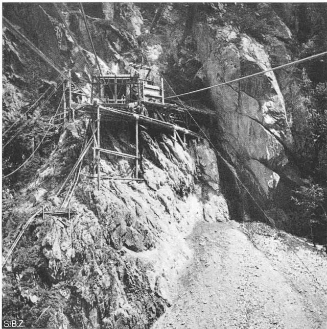
Abb. 7. Baufenster Mittagfluh des Zulaufstollens
