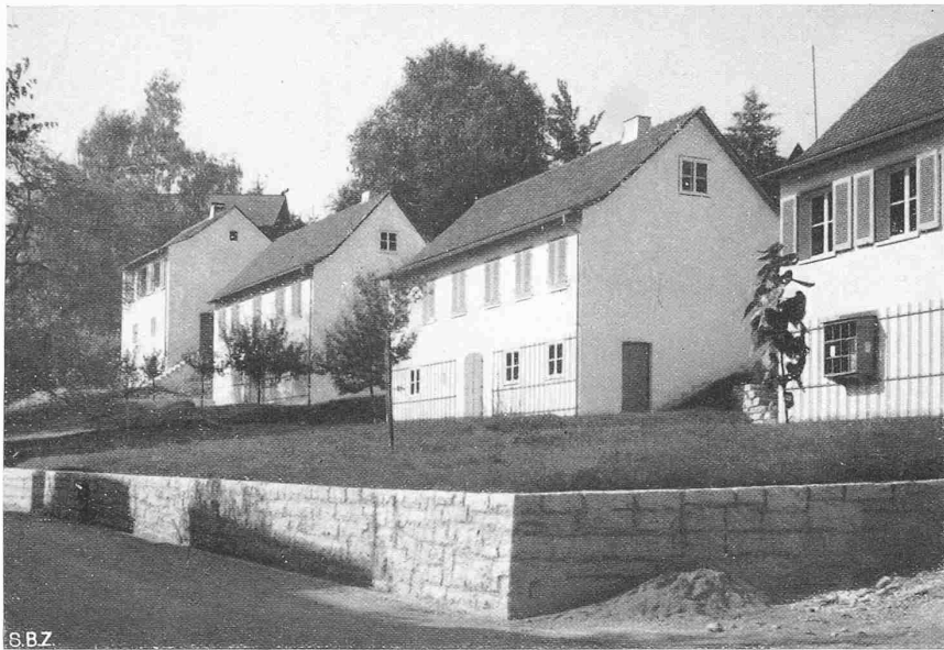
Abb. 3. Häuser «B» am Beckengässchen, zu hinterst Haus «A»
