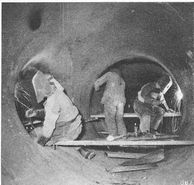
Abb. 25. Schweißarbeiten in der Verteilung
