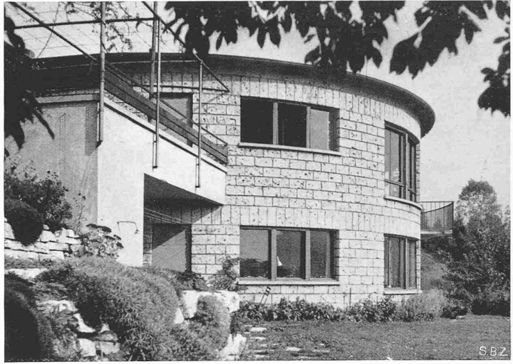
Abb. 2. Ansicht aus Westen, in Untergeschoss-Höhe
