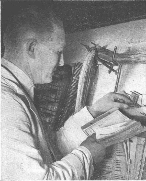
Kontrolle der Telephonkabel
