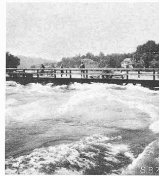
Abb. 1. Hölzerner Rheinsteg bei HW mit Steinen beschwert
