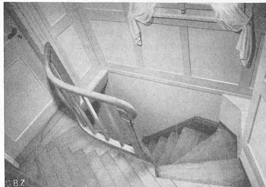
Abb. 7. Treppenaufstieg in den I. Stock
