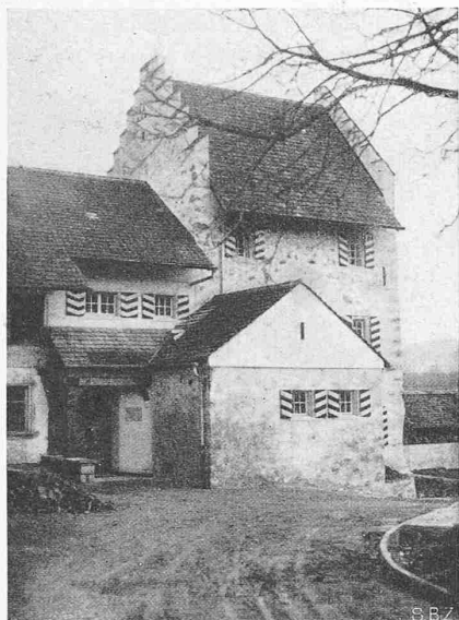
Abb. 3. Ansicht aus Nordost
