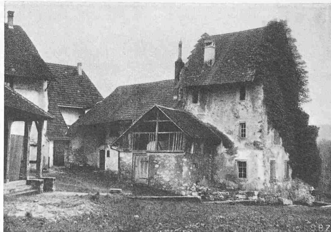
Abb. 1. Ehemaliger Zustand des Schösschens Altenburg
