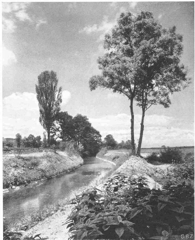
Abb. 3. Korrigierter Aabach unterhalb Mönchaltorf
