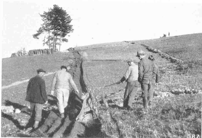
Abb. 11. Pflügen mit elektrischer Seilwinde
