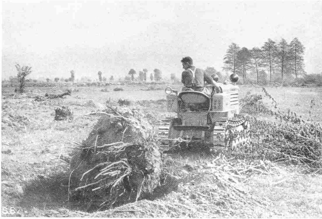
Abb. 7. Ausreissen von Wurzelstöcken mit dem Raupentaktor
