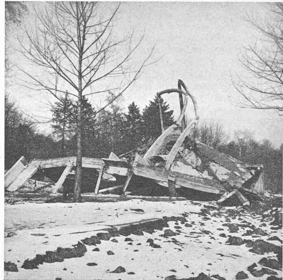
Abb. 12. Südliche Seitenansicht im letzten Bewegungsstadium: in dieser Form blieb das ganze Gebilde vorerst in Ruhe
