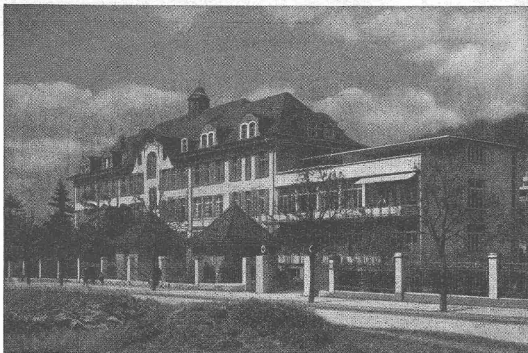
Auch das Städt. Krankenhaus Baden ist mit einer Albis-Anlage ausgerüstet
