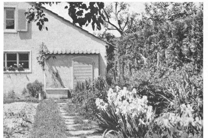
Abb. 7. Ostecke der Südostseite, mit Eingang zur Garage
