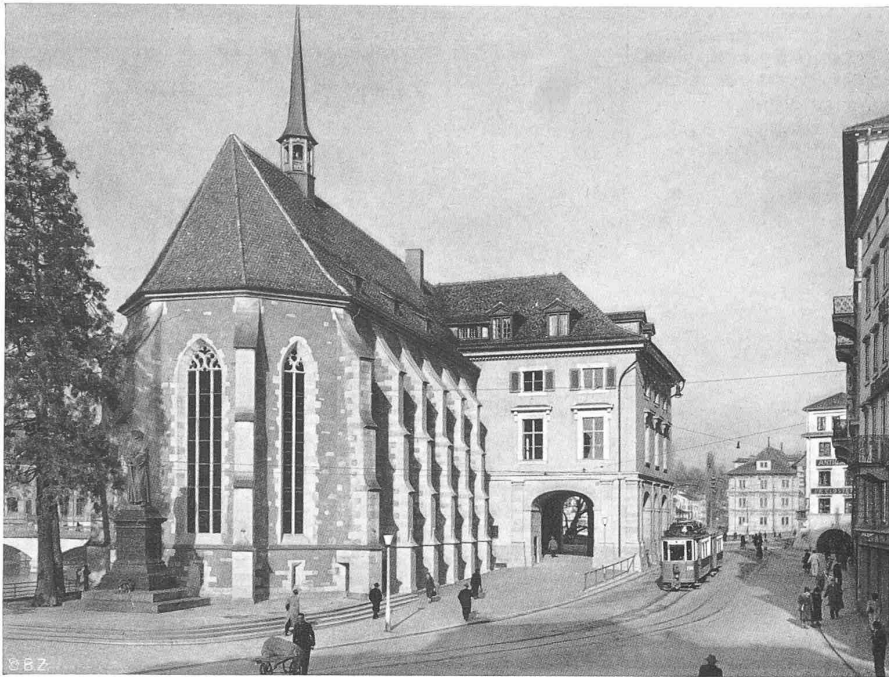
Abb. 5. Ansicht der Wasserkirche aus Südost mit dem Helmhaus-Durchgang Photos: Abb. 4 Wolf-Bender; Abb. 5, 12 und 13 Beringer & Pampaluchi, Zürich
