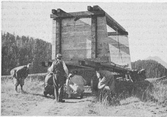
Abb. 6. Transport des hölzernen Durchfluss-Kastens
