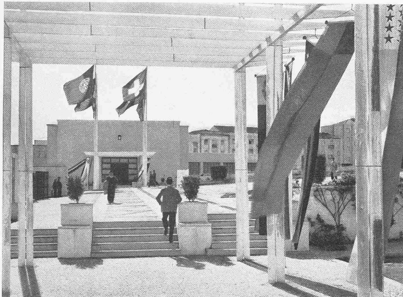
Abb. 6. Blick aus Halle III gegen den Eingang in Halle I
