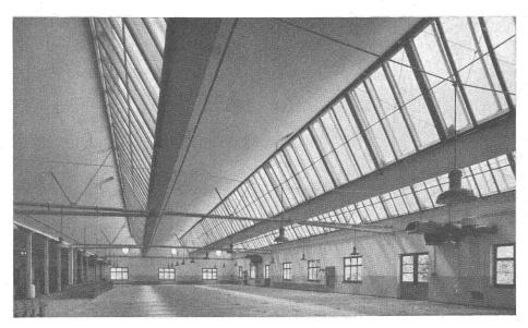
Spinnerei-Neubau mit Shed-Dachung eigenen Systems: Säulenfrei, leicht und hell
