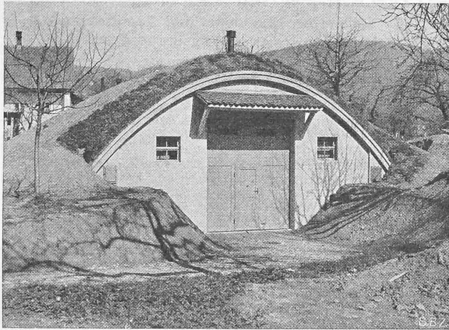
Abb. 10 und 11. Backstein-Erdkeller nach Entwurf des Techn. Bureau des Verbandes Schweiz. Ziegel- und Steinfabrikanten, Zürich
