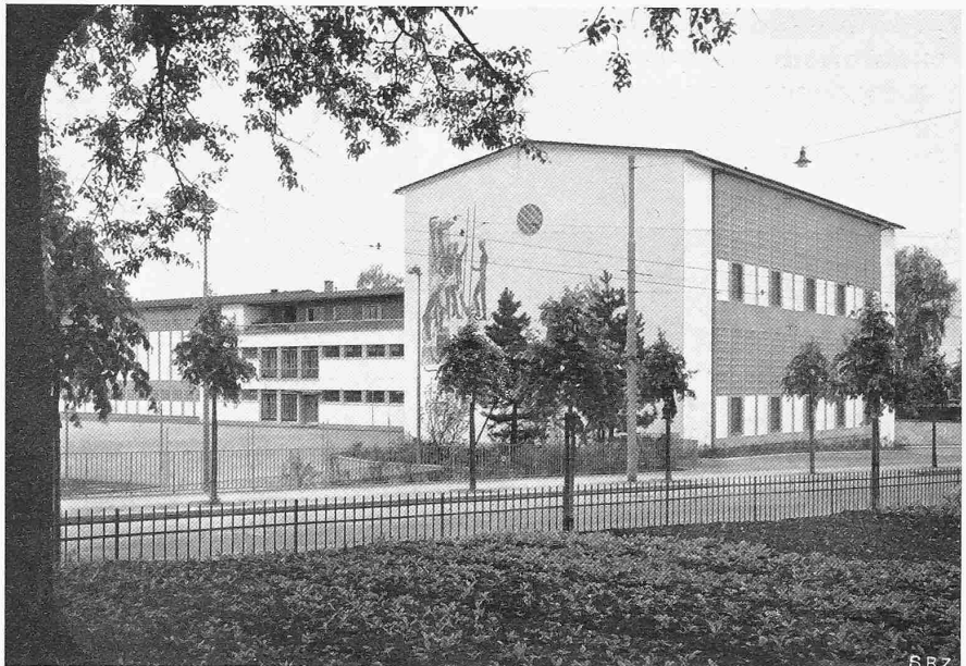
Abb. 3. Ansicht aus Norden, von der Gloriastrasse aus
