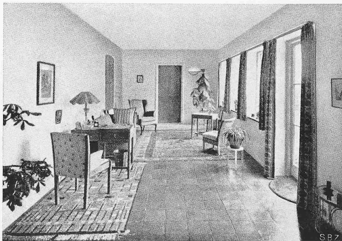
Abb. 9. Gartenhalle, Boden mit zinnberroten handgestrichenen Tonplatten belegt, Holzwerk silbergrau gedämpfte Eiche
