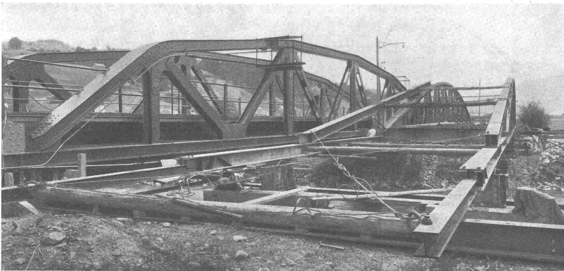
Thurbrücke Ullsbach SBB-Strecke Wattwil-Nesslau
