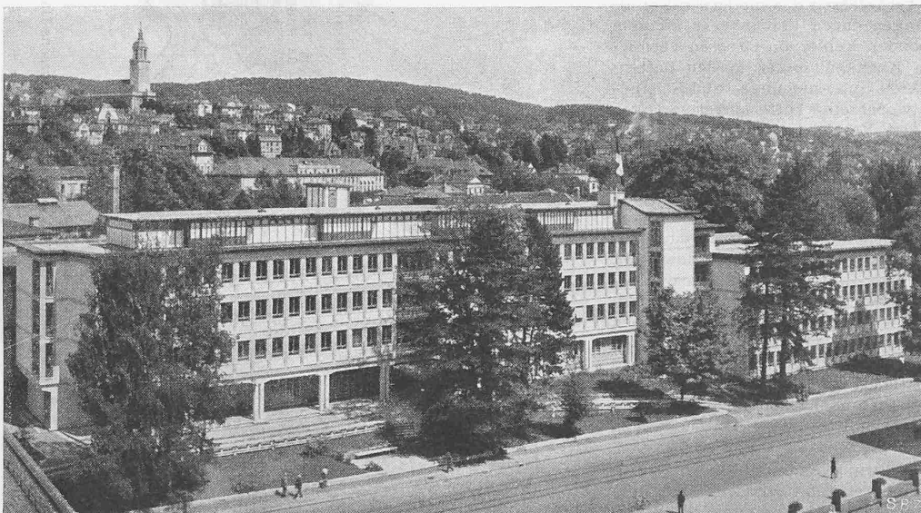
Kantonspital Zürich. Polikliniktrakt aus Westen, vom Dach der E. T. H. aus gesehen Architekten H. WEIDELI, HAEFELI MOSER STEIGER, LEUENBERGER & FLÜCKIGER, ARTER & RISCH, J. SCHÜTZ, R. LANDOLT, Dr. H. FIETZ
