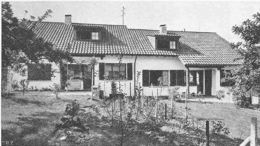
Abb. 7. Südseite Doppelhaus A
